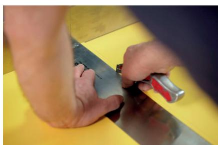
3. En la práctica, la separación de la tira de pavimento inferior con la cuchilla en forma de gancho ha mostrado resultar de utilidad. No se recomienda cortar con el corte del borde inferior tras colocar el pavimento, ya que existe riesgo de presionar la costura.
