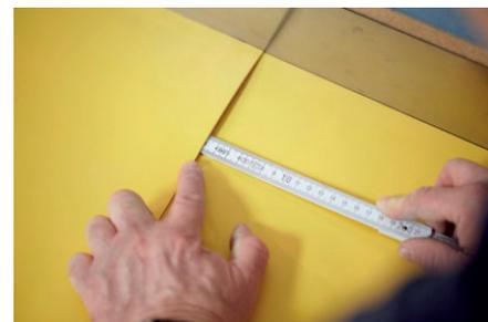
2. Con la guía de la regla (aprox. 1 cm de distancia hasta los bordes cortados del rollo), rectificar los bordes cortados de fábrica con la recortadora nora<sup>®</sup> o la cuchilla recta (cuchilla trapezoidal) y, al mismo tiempo, cortar el rollo de debajo. De forma alternativa a la recortadora nora<sup>®</sup>, también puede utilizarse la herramienta Railcut (del fabricante Wolff), sin embargo, **no** la Linocut.
